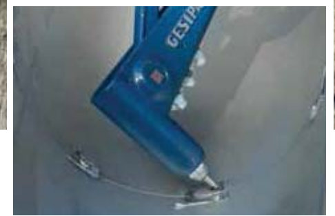
verzinkte Edelstahlnieten einsetzen
