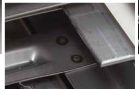
zwei Schweißpunkte fixieren Bestandteile
