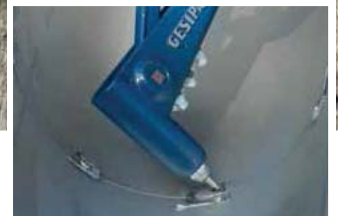
verzinkte Edelstahlnieten einsetzen
