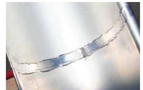
saubere und dichte Lötnaht an einer Dachrinne
