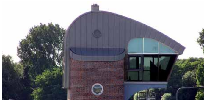
Weserschleuse in Bremen, AME verzinkt in 1.4404
