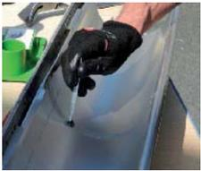
Anschließend wird mit dem LötKolben und dem Lötzinn die Lötnaht hergestellt.
